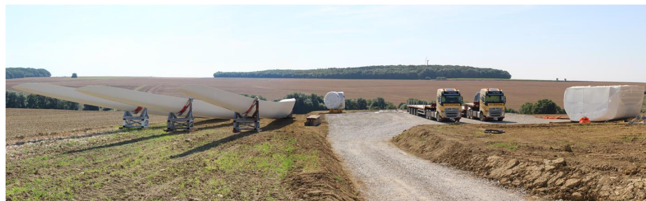
Eléments d'éoliennes avant montage (Source : Ora environnement)
