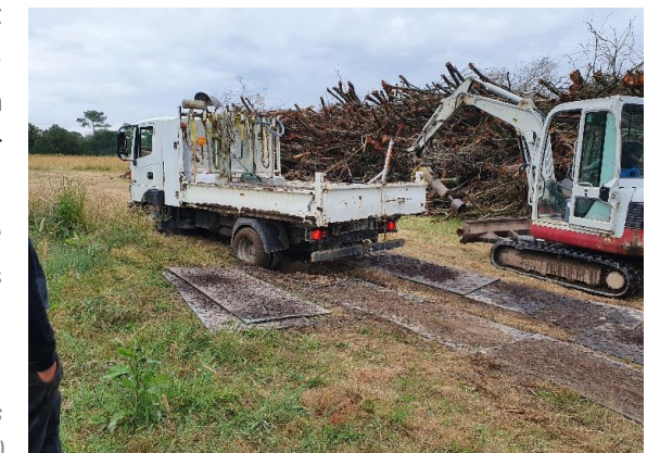
Mise en place d'une piste sur plaque et piste créée avec des plaques métalliques (Source : Synergis Environnement)
