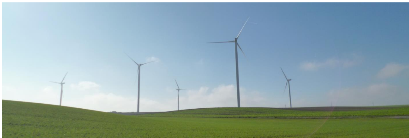
Figure 1 : Parc éolien de Terre de Beaumont dans le département de l'Aisne, projet porté par wpd (Source : wpd onshore France)
