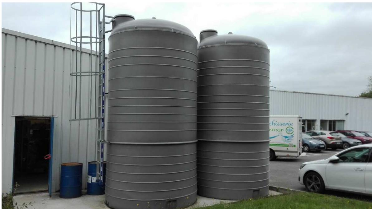
Figure 15 : cuves de 20 m<sup>3</sup> servant au stockage de l'eau de forage
