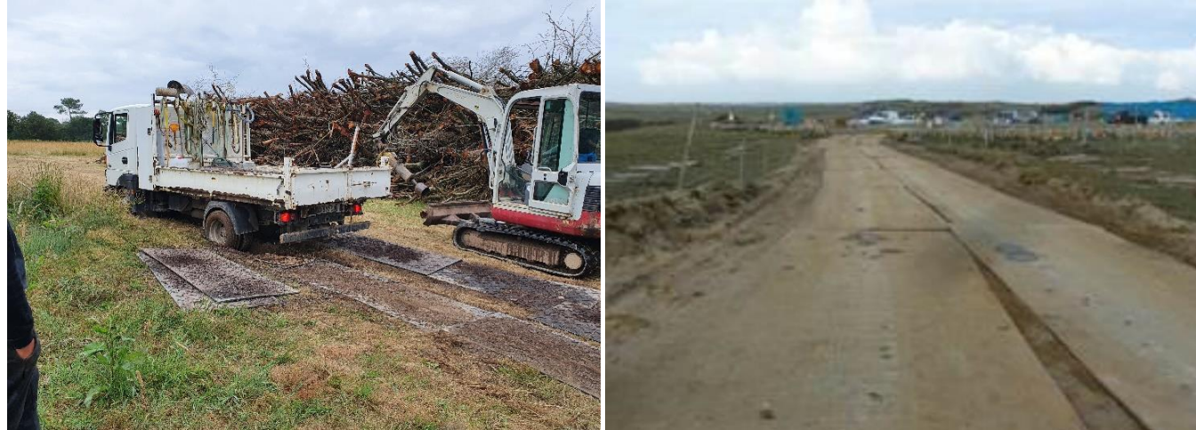
Mise en place d'une piste sur plaque et piste créée avec des plaques métalliques (Source : Synergis environnement)
