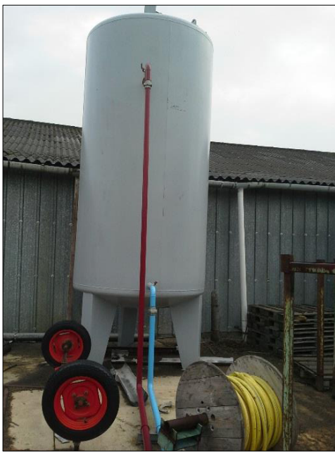
Figure 25 : Localisation de la cuve aérienne d'eaux d'extinction incendie 11 m 3
