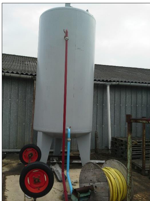
Localisation de la cuve aérienne d'eaux d'extinction incendie 11 m 3
