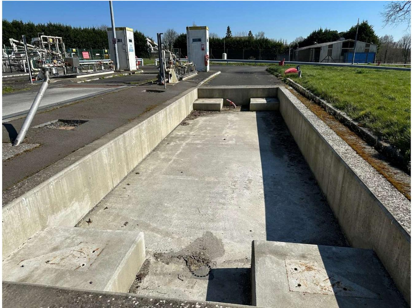
**Image 3 : Illustration retrait pont bascule et arrosage camion**
