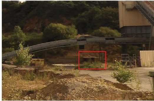
Figure 42. Vue du local technique servant de gîte à chiroptère (IGC)
