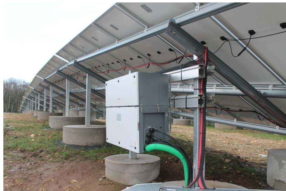
Figure 10 : Photo d'un onduleur d'un projet en phase de construction (FS du Cosquer, ancienne décharge, une réalisation IEL)
