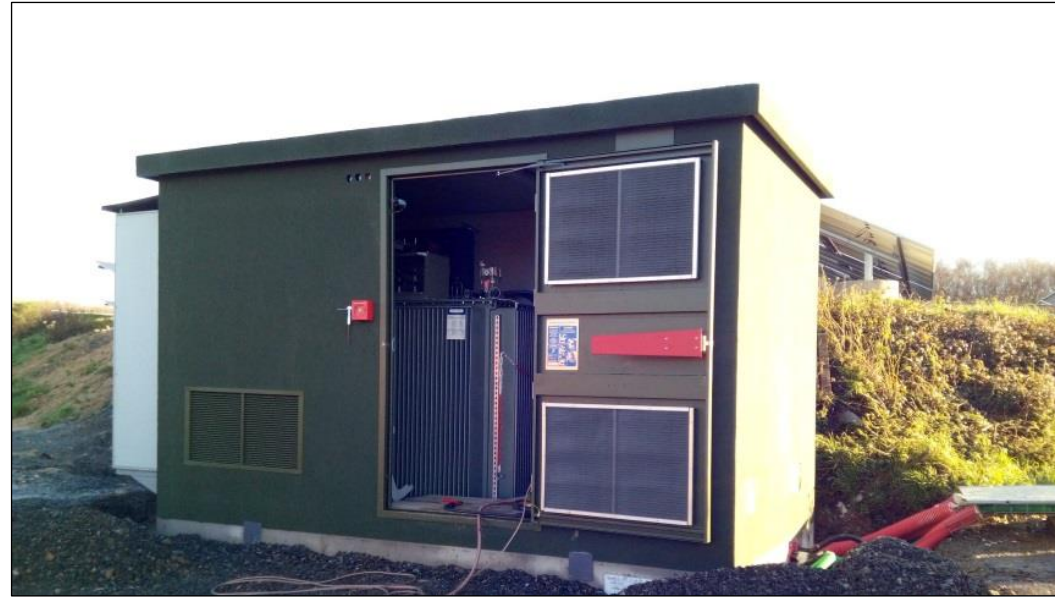
Figure 9: Photo d'un poste de transformation d'un projet en phase de construction (Source : IEL)
