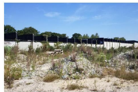
Ancien bâtiment militaire
