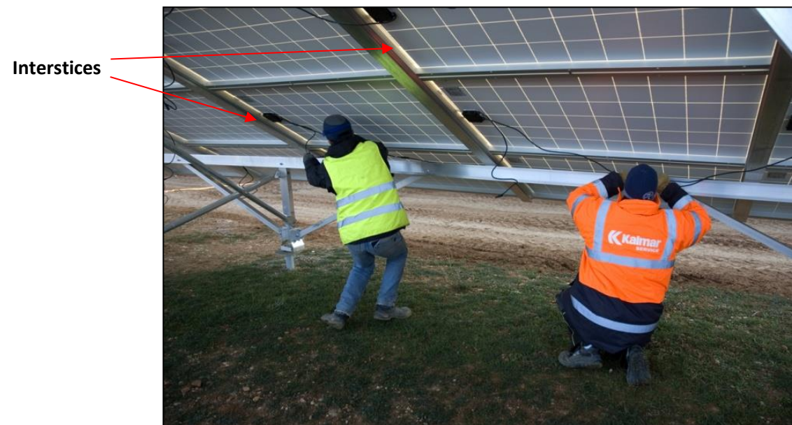
Figure 5: Vue des interstices entre chaque panneau (Source : IEL)
