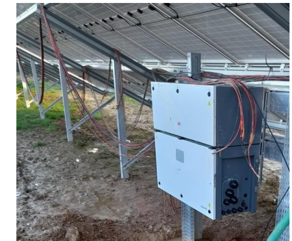
Figure 30 : Onduleurs fixés sur les structures photovoltaïques (FS Beauvoir, photos prises en phase construction, IEL)
