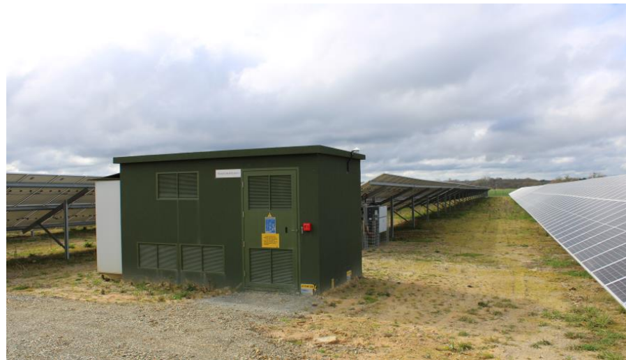
Figure 31 : Poste de transformation d'une centrale photovoltaïque en construction par IEL
