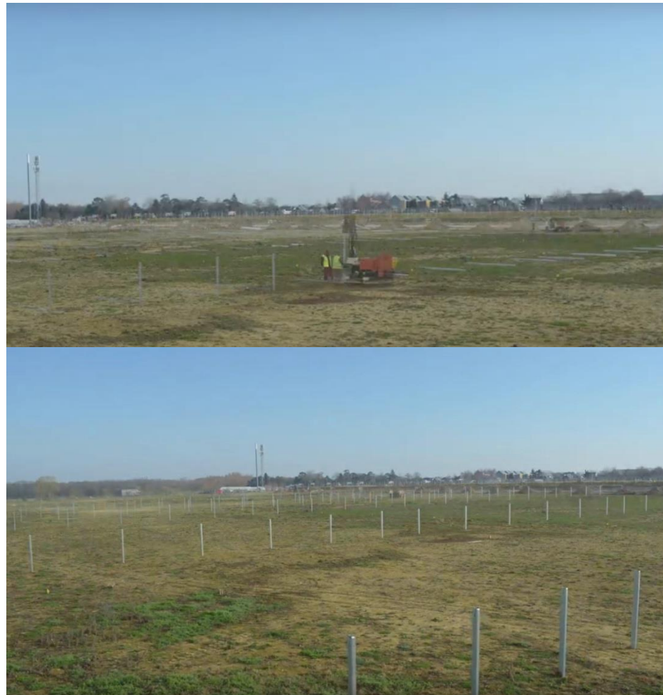
Figure 23 : Mise en place des pieux battus - photos de la construction de la FS Marc Energies, une réalisation IEL
