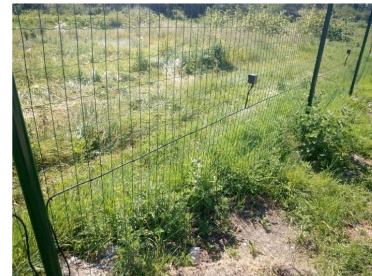
Figure 18 : Système de vidéo-surveillance avec détection infrarouge (à gauche) et du câble de détection (à droite) – photos prises sur les centrales solaires d'IEL à Machecoul (44) et à Descartes (37)
