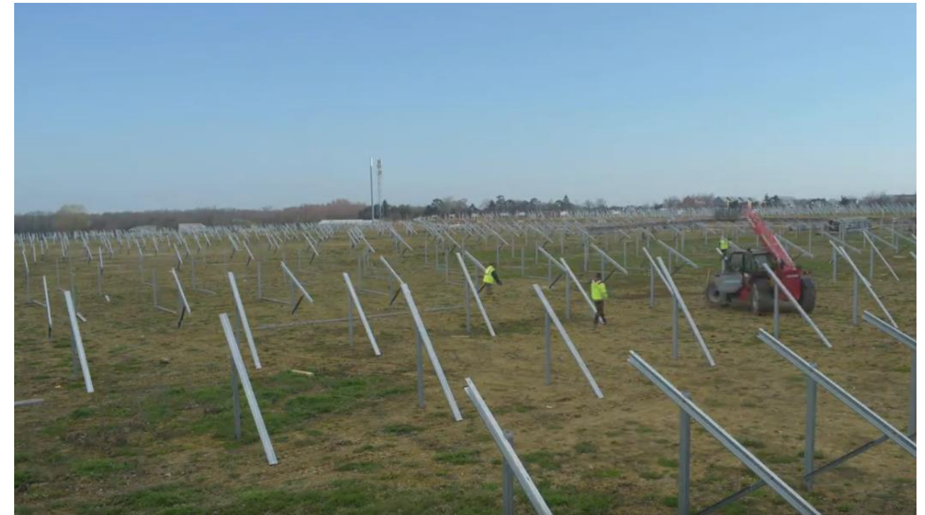
Figure 25 : Assemblage des structures porteuses - photos de la construction de la FS Marc Energies, une réalisation IEL
