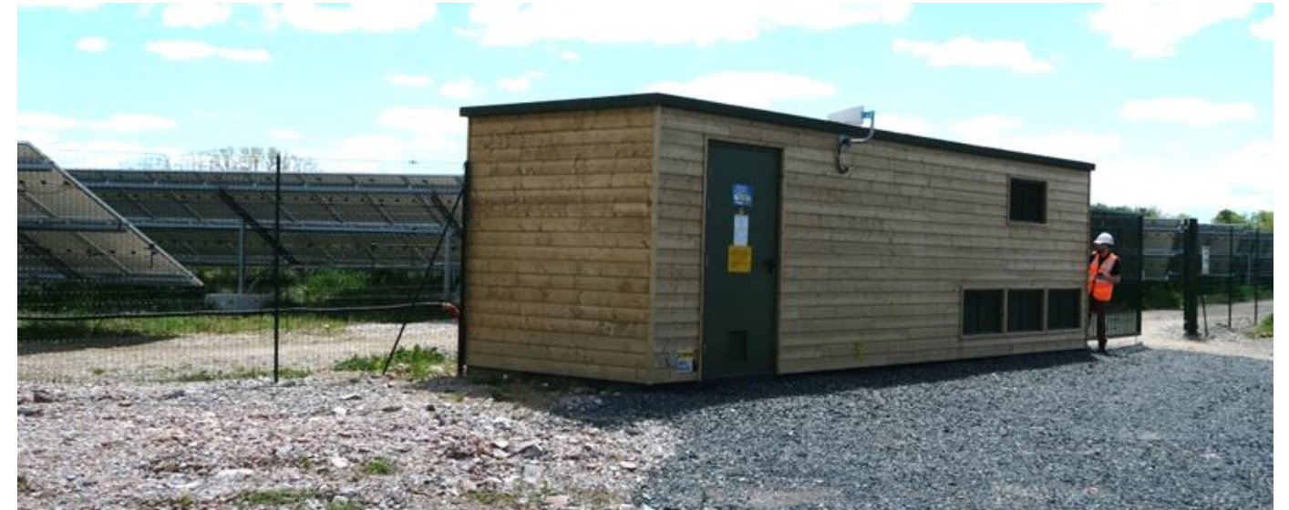
Figure 33 : Poste de livraison avec bardage bois, projet en phase travaux (source : IEL)
