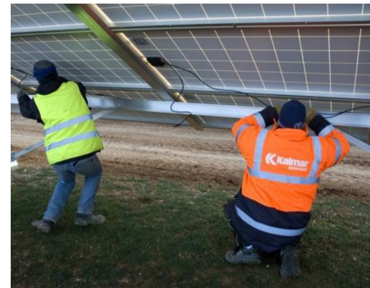
Figure 28 : Câblage des panneaux photovoltaïques
