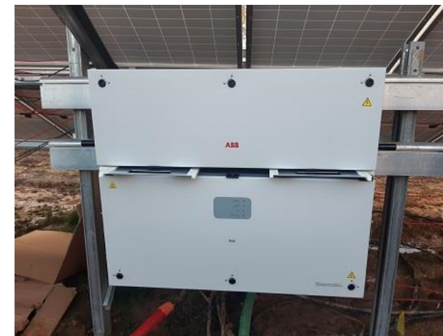
Figure 30 : Onduleurs fixés sur les structures photovoltaïques (FS Beauvoir, photos prises en phase construction, IEL)
