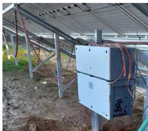
Onduleurs fixés sur les structures photovoltaïques (FS Beauvoir, photos prises en phase construction, IEL), Etude d'impact, p 49.
