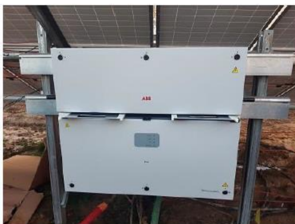
Onduleurs fixés sur les structures photovoltaïques (FS Beauvoir, photos prises en phase construction, IEL), Etude d'impact, p 49.
