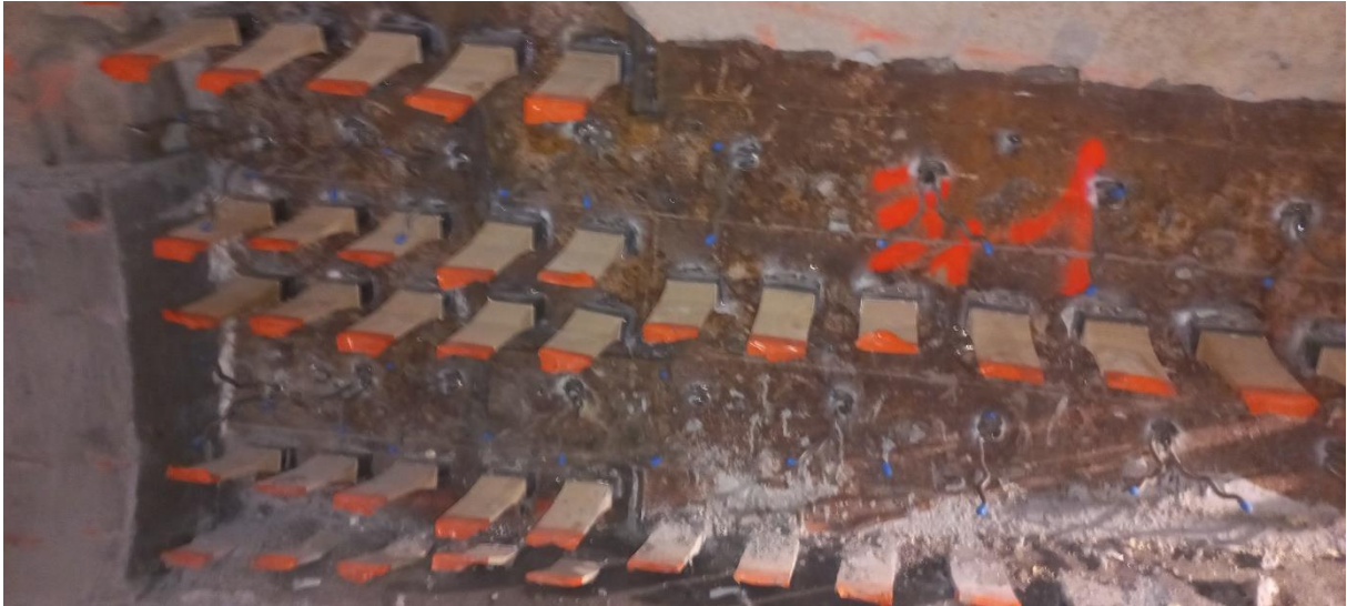
Réfection de la zone buse du four
