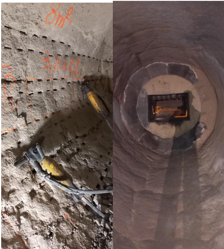
Réfection de diverses zones du four et de la post combustion
