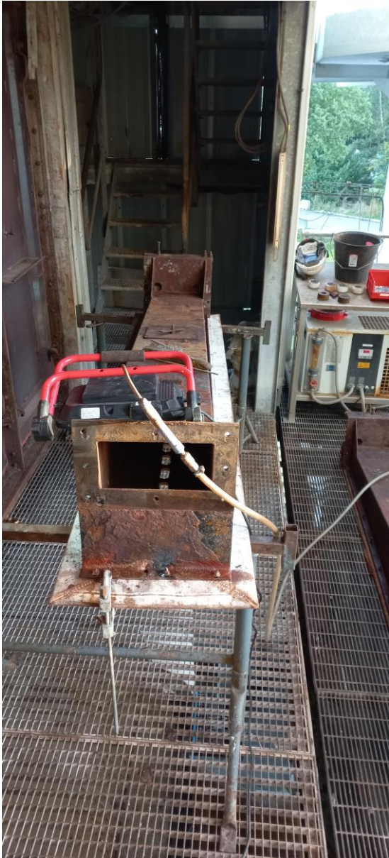
Réfection buses de décolmatage filtre Genevet
