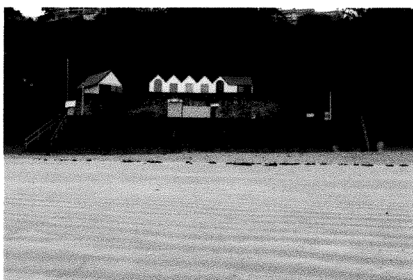
Vue de la digue
