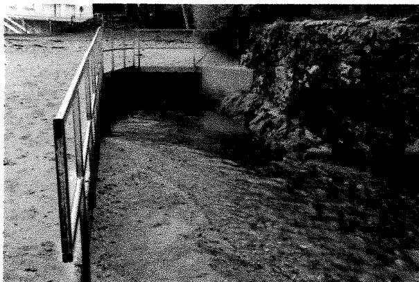
Vue du pont-cadre
