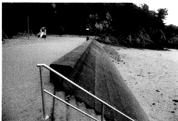
Vue de la digue
