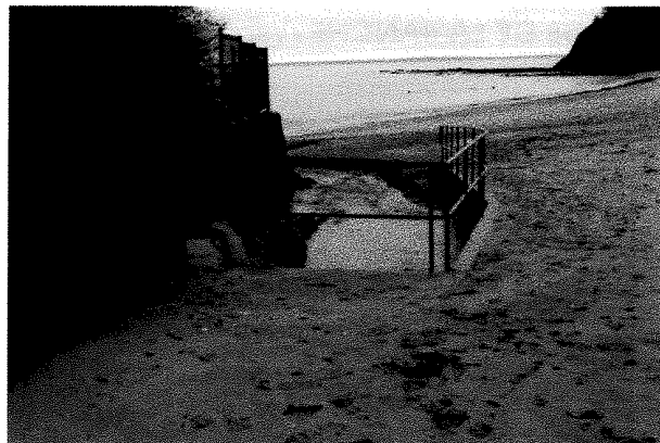
Vue du pont-cadre
