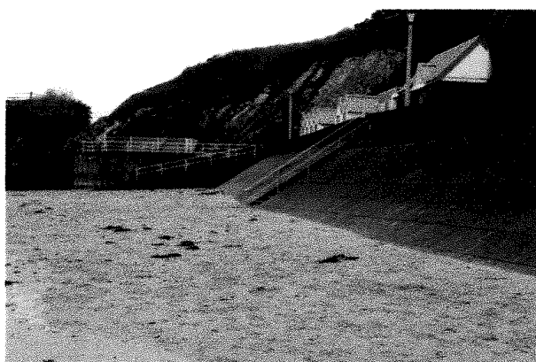
Vue de la digue
