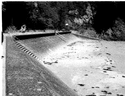
Vue de la digue et de la rampe
