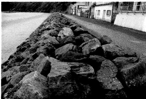
Vue de la digue et de l'enrochement
