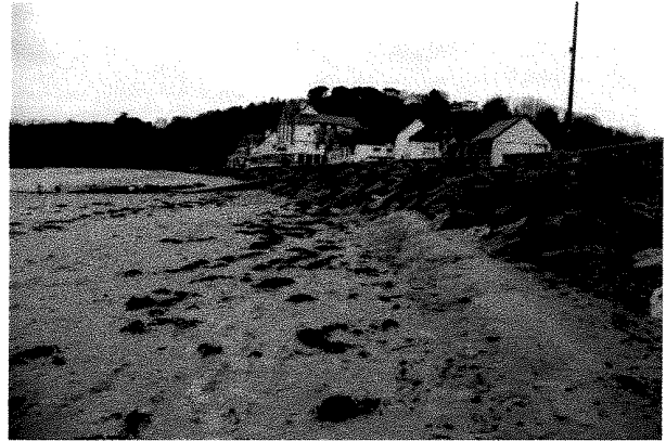
Vue de l'enrochement
