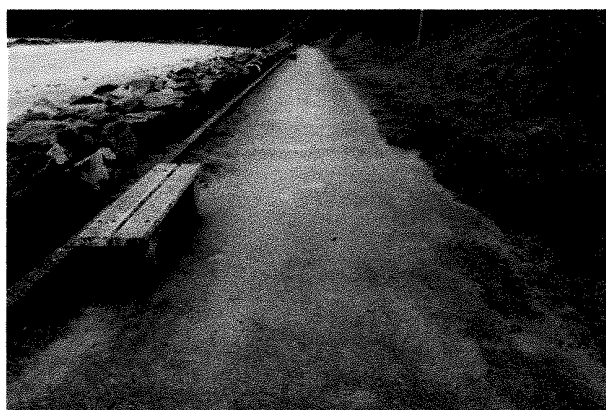
Vue de la digue et de l'enrochement
