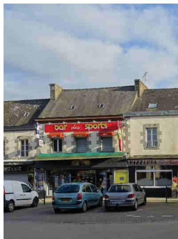
bâti ancien en pierre R+1 avec signalétique hétérogène place François Gicquel
