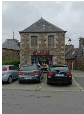
bâti ancien en pierre R+2+combles, vitrine largement ouverte sur la Grand rue
