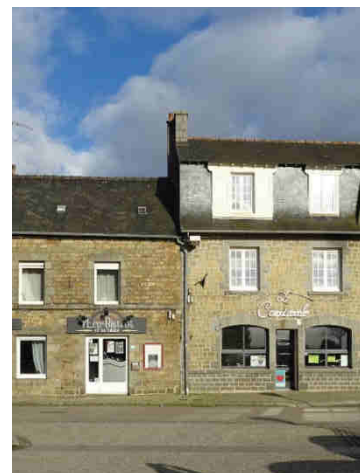
bâti ancien en pierre R+1 à R+2 avec peu de signalétique place François Gicquel
