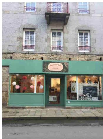
bâti ancien en pierre R+2+combles, vitrine largement ouverte sur la Grand rue
