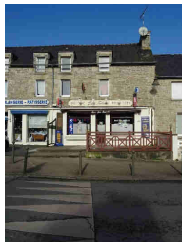
bâti ancien en pierre R+1+combles, avec rez-de-chaussée commercial et logement aux étages
