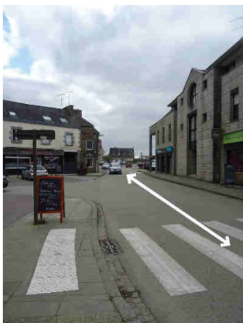
route d'accès traversant le centre-bourg et longeant les places de la République et F. Gicquel
