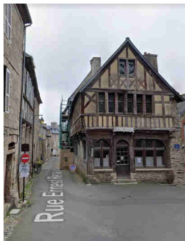
bâti ancien à pans de bois, à l'angle de la rue Ernest Renan
