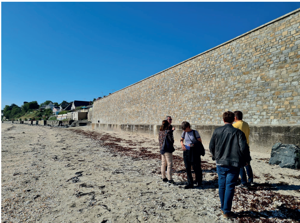
Vue du mur de soutènement - 08-07-2022
